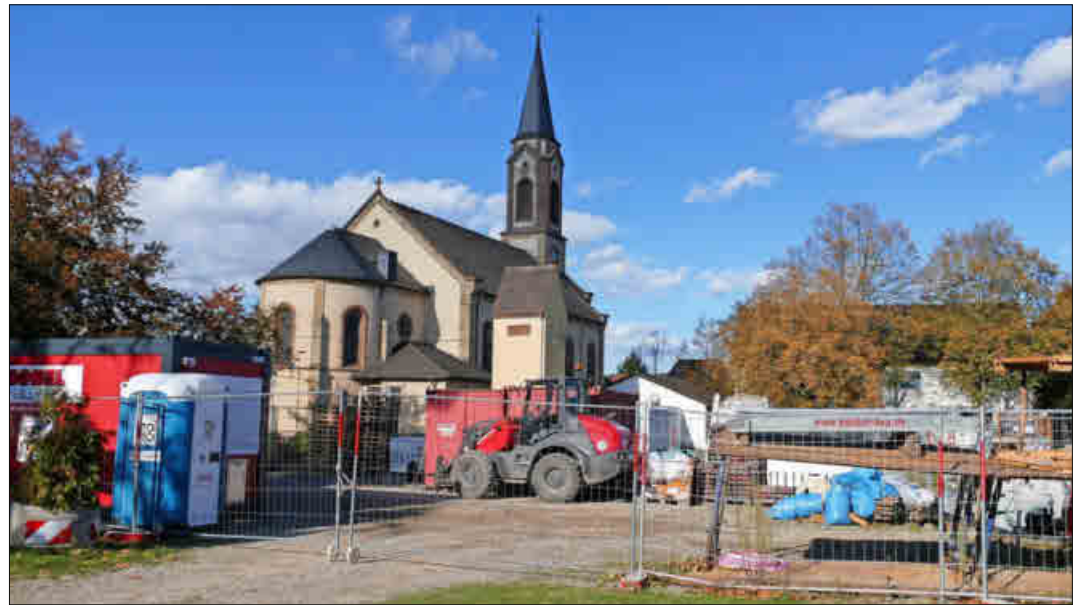
Maschinen und Material auf dem Platz hinter Kirche und Rathaus werden im Zusammenhang mit der Rheinstraßen-Sanierung bereitgehalten. Ab Sommer 2022 könnte hier die „Neue Mitte“ gebaut werden. FOTO: FRANK SCHOCH
